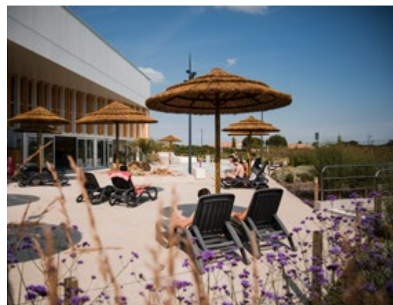
Nouveaux aménagements des espaces extérieurs réalisés en 2024
