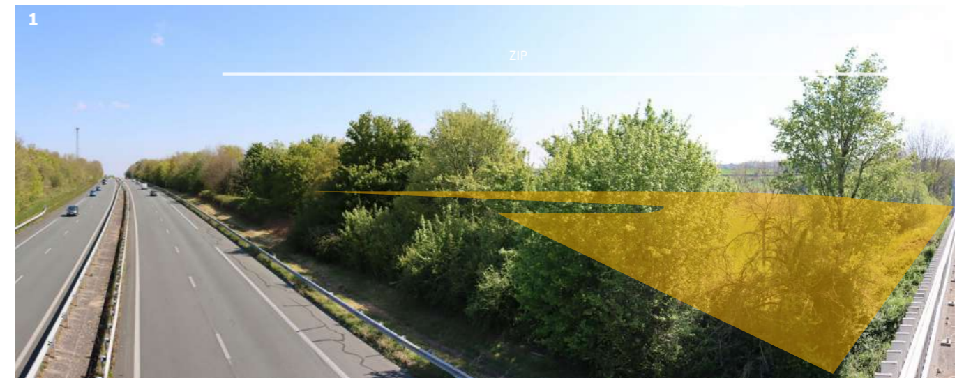
Photographie 30. Depuis le pont franchissant l'autoroute A10 (ZIP partiellement visible)
