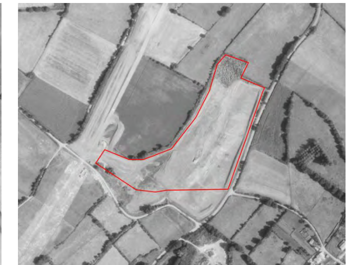
Figure 8. Photo Aérienne de 1979 (ZOOM LOT 2) – Au début de la phase travaux du tronçon de l'autoroute A10 ( https://remonterletemps.ign.fr/ )
