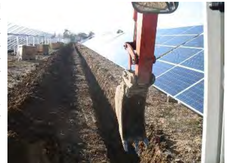
Photo 33. Exemple de tranchée entre deux tables photovoltaïques
