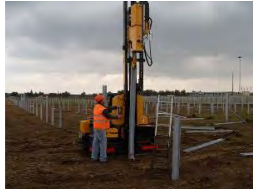
Photo 29. Exemple de fondation type pieux battus
