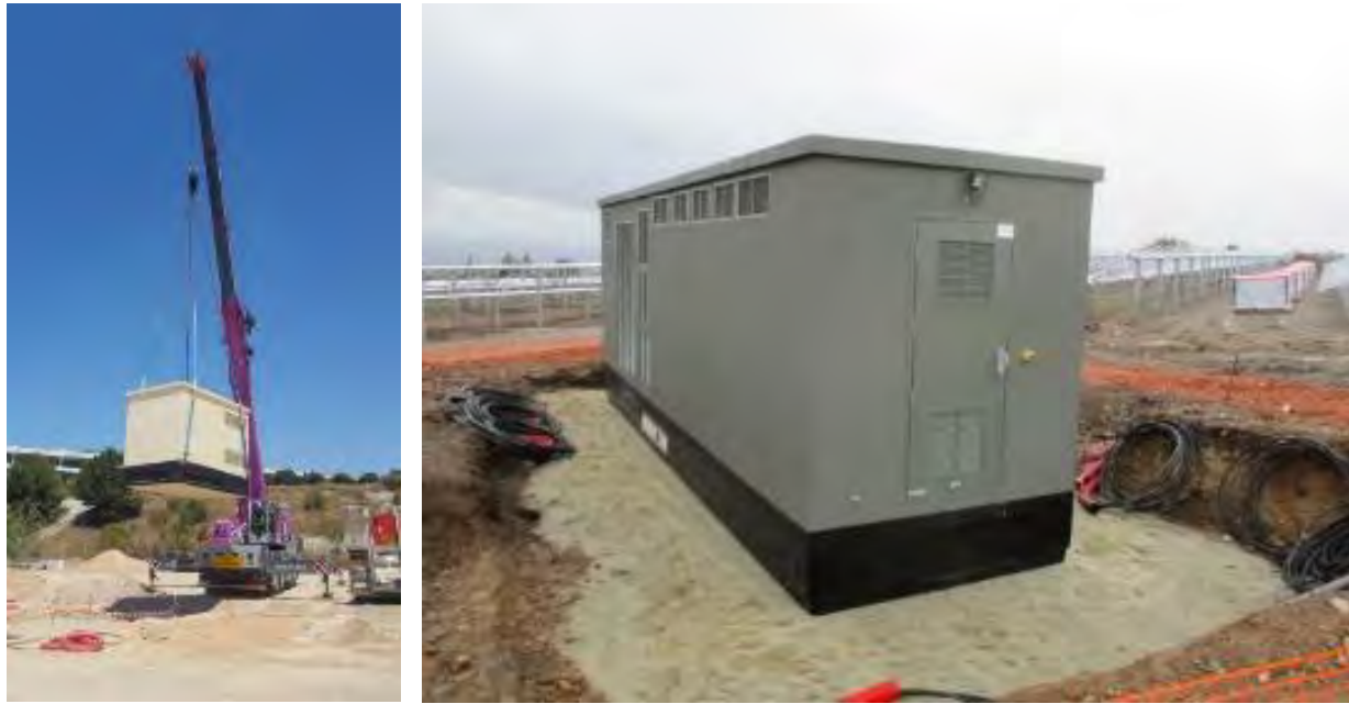
Photo 34. Installation d'un poste électrique
