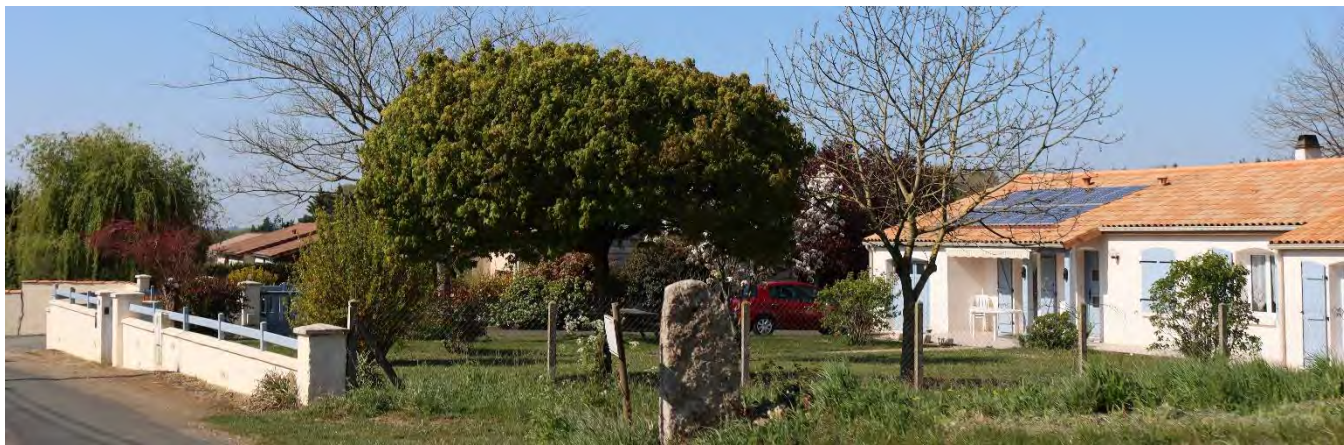
Photo 6. Habitation localisée au niveau du lieu-dit de l'Houmeau - secteur nord de la ZIP
