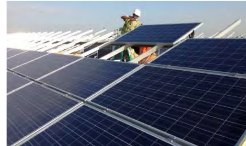
Photo 32. Exemple de mise en place des panneaux sur les structures
