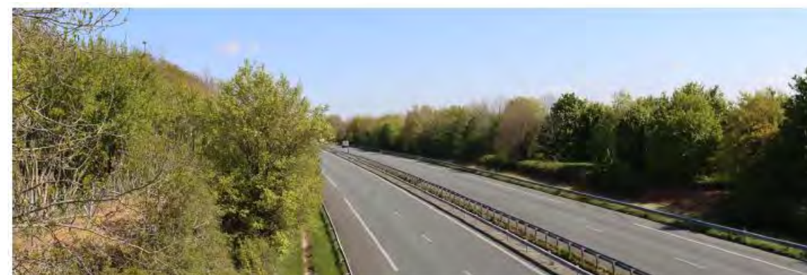
Photo 16. Autoroute A10 bordée de talus plantés
