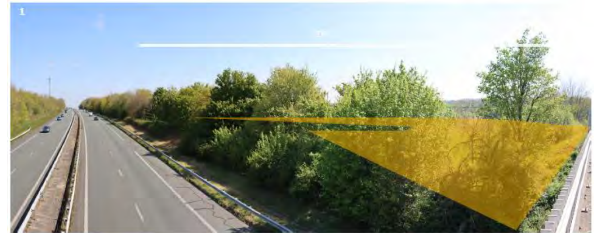
Photo 20. Depuis le pont franchissant l'autoroute A10 (ZIP partiellement visible)
